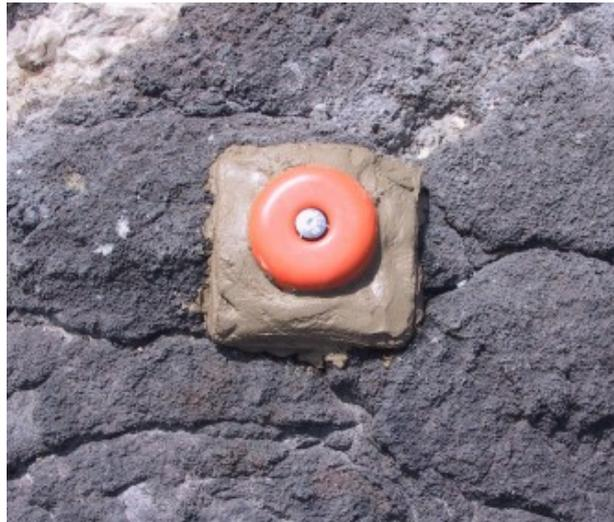
**figura 3 Detalle de Base hormigonada con cabeza metálica y clavo de acero**
