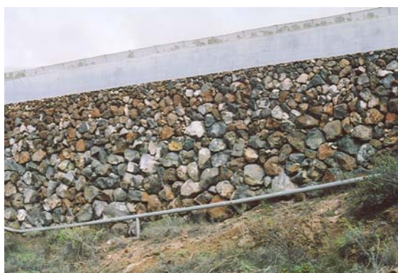
Figura 13 Muro de contención de la “sorriba” en preparación
