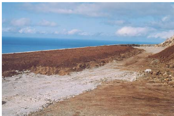
Figura 12 Amagar. Preparación de sorriba con suelo transportado
