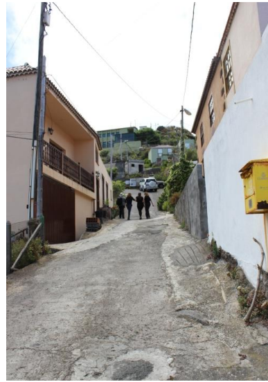
Imagen 23. Vista del tendido eléctrico en una de las calles centrales del núcleo de población. Fuente: elaboración propia.
