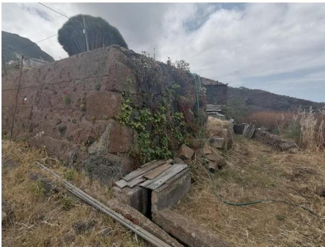
Imagen 34. Estanque de mampostería tradicional y atarjea para riego por gravedad. Fuente: Elaboración propia.
