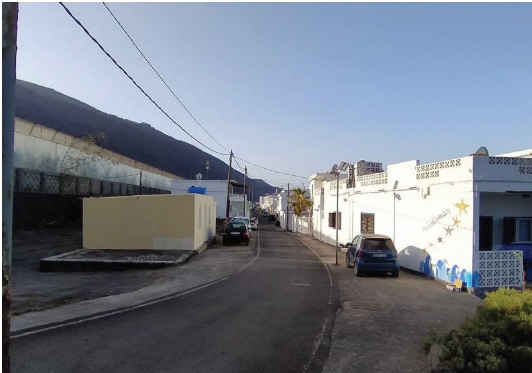
Frente costero edificado en zona sur del núcleo de El Remo
