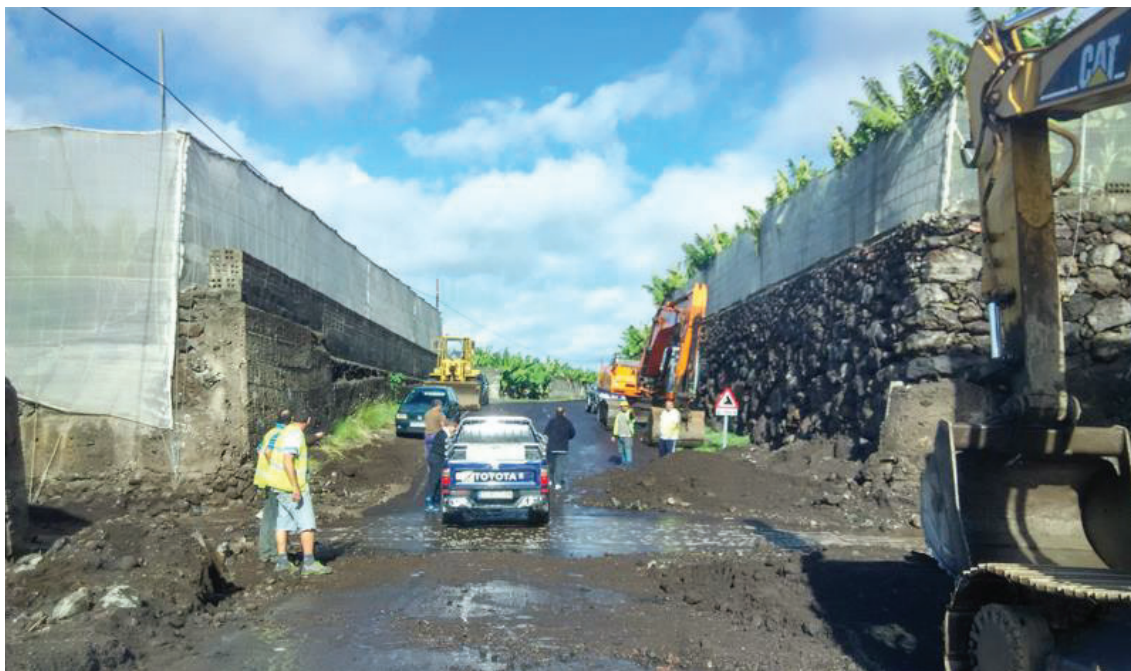
Trabajo de limpieza de la carretera LP-213 después de una avenida provocada por las lluvias. Fuente: viajamosjuntos.net
