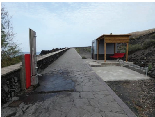
Cuarto de servicios y ducha en el acceso norte.
