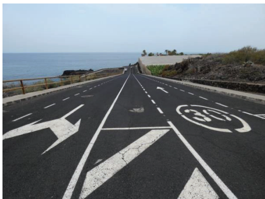
Vista general del acceso norte con sus estacionamientos en línea (3 Uds.), visto desde la LP-213.
