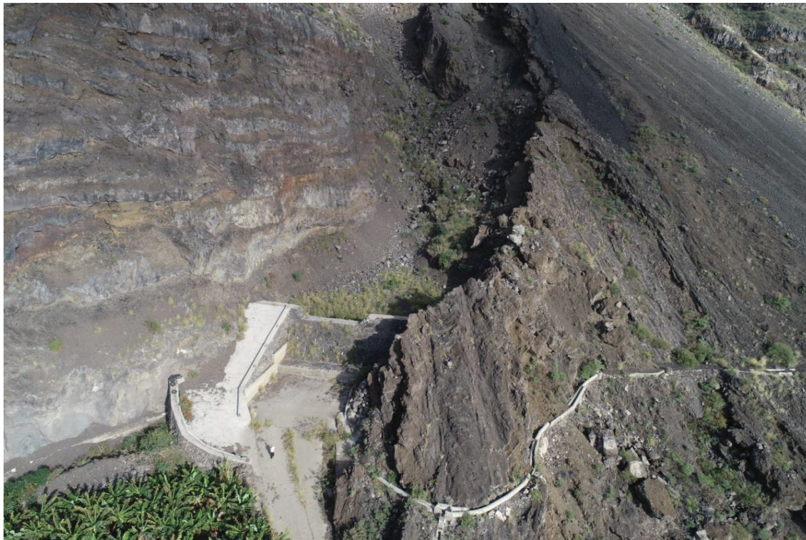
Vista aérea del encauzamiento del barranco de Los Guanches en una pista agrícola a su entrada en el Paisaje Protegido.
