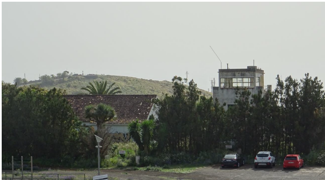
Detalle de la antigua torre de control y de la cubierta de la terminal.
