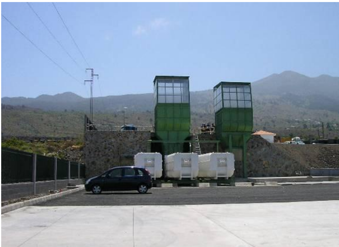
Planta de trasferencia de Los Llanos de Aridane
