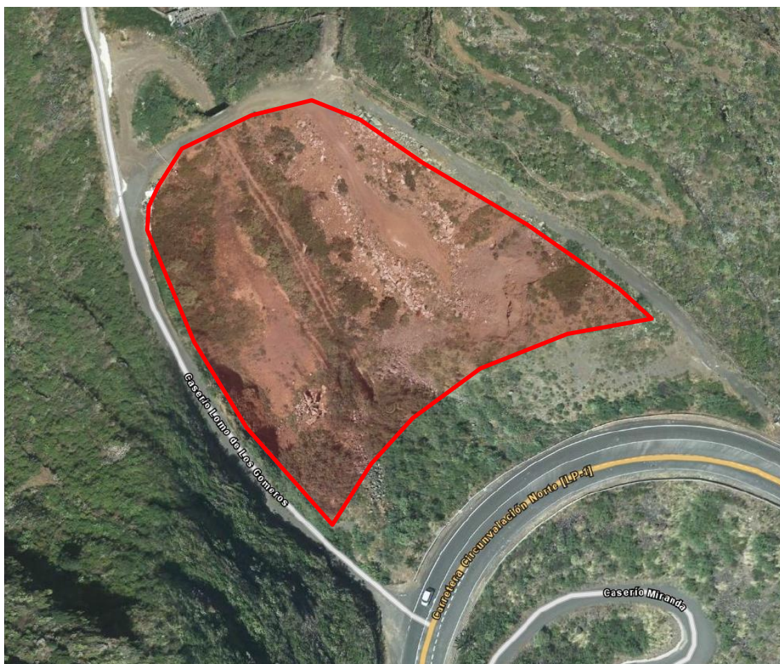
ÁREA PREVISTA PARA LA EJECUCIÓN DEL CENTRO DE GESTIÓN DE RESIDUOS DE LA ZONA ESTE (PLANTA DE TRSFERENCIA Y BASE LOGÍSTICA ASOCIADA) ACCESO DESDE LA CARRETERA LP-1
