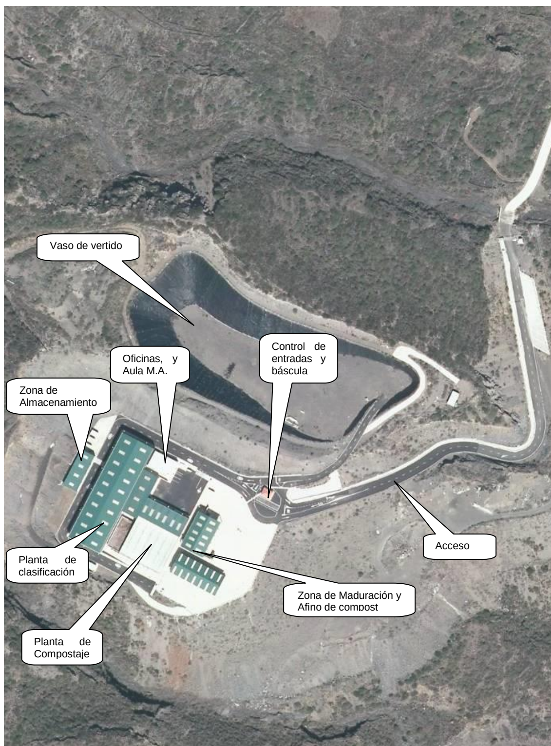
Figura 7: Vista general de las instalaciones correspondientes a la 1ª Fase de desarrollo del Complejo Ambiental de Los Morenos.
