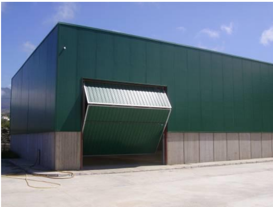
BASE LOGÍSTICA DE VEHÍCULOS RECOLECTORES T.M. DE LOS LLANOS DE ARIDANE
